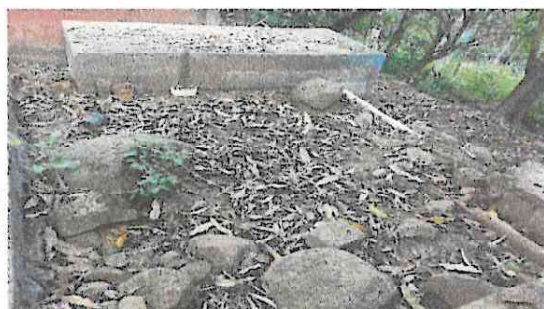
Foto 6: PAVIMENTACIÓN DE PATIO
