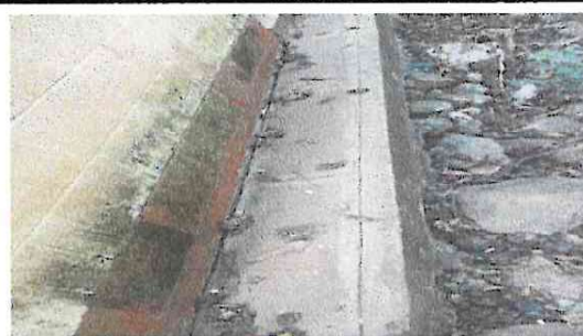
Foto 2: REPARACIÓN DE BANQUETAS
