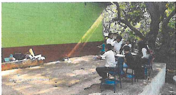
Foto1: REPARACIÓN DE PISO DE TORTA DE CONCRETO POR PISO CERAMICO
