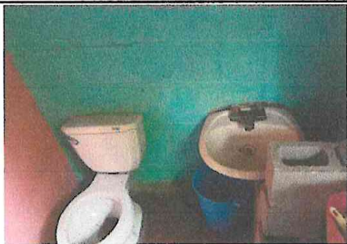
Foto 1: SUSTITUCIÓN DE SANITARIOS.
