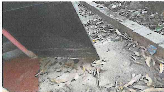
Foto 4: REPARACIÓN DE PUERTAS DE SANITARIOS Y AULAS
